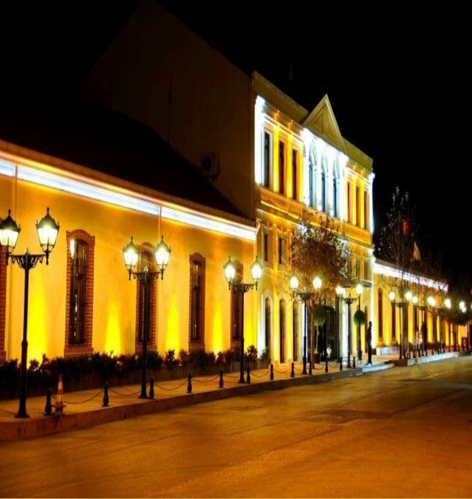
Montania Otel – Tren Garı Binası
